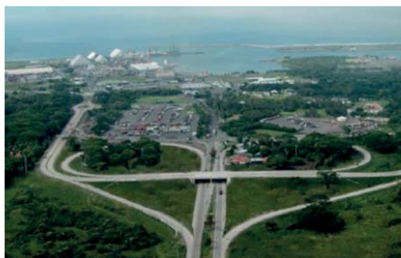
Fuente: Foto aérea de la terminal portuaria de Quetzal, tesis de la autora.
