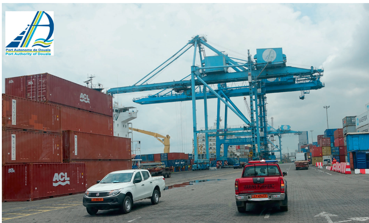
Figure 6 : Port Autonome de Douala, Terminal à conteneurs.
