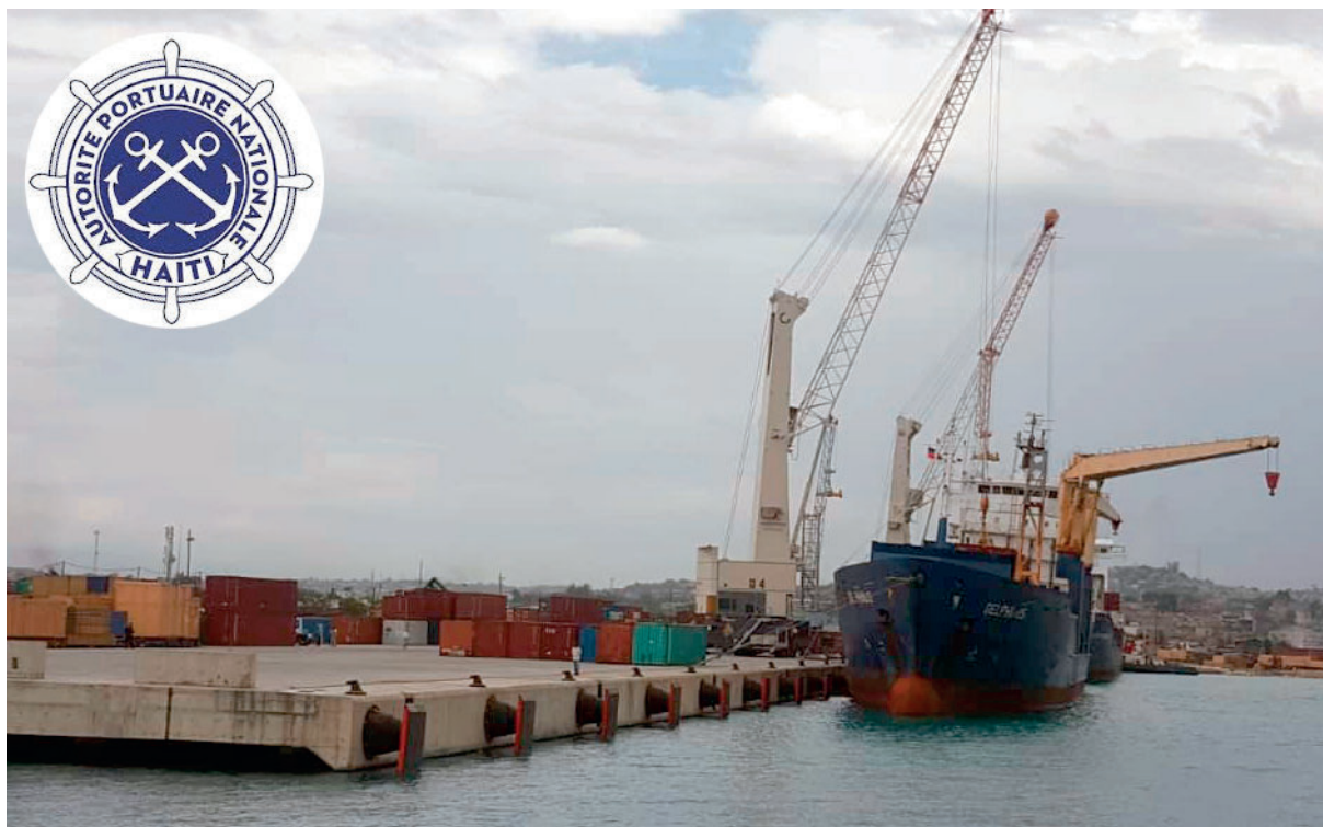
Figure 14 : Quai du port de Port-au-Prince.
