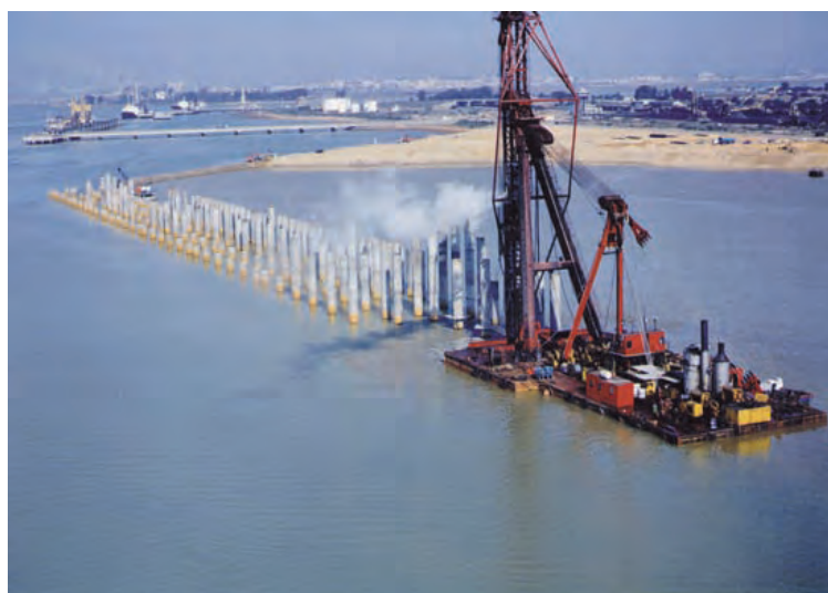
Figura 8.2.5.e A Hinca de pilotes con cabria
