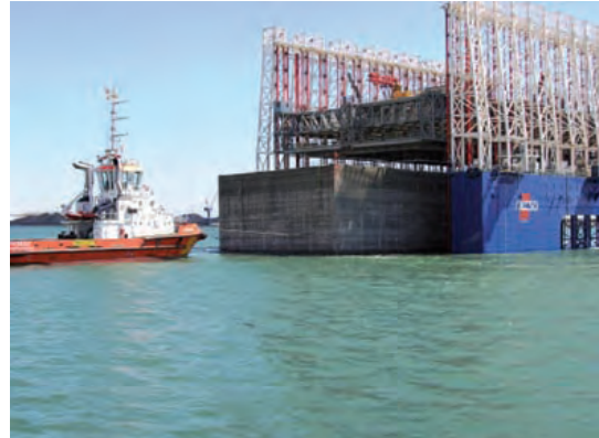
Figura 6.12.7 B Botadura del cajón
