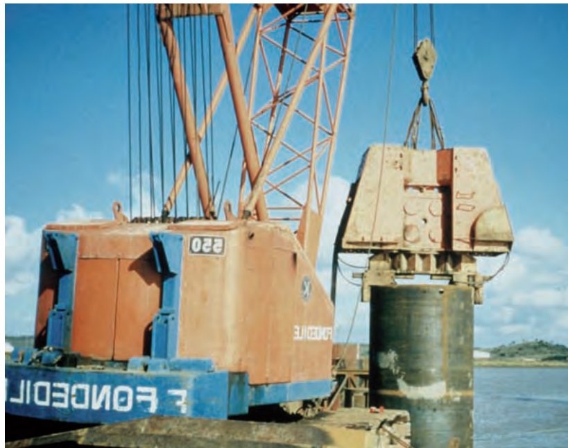
Figura 8.2.5.e B Hincada de pilote metálico con martillo vibrador
