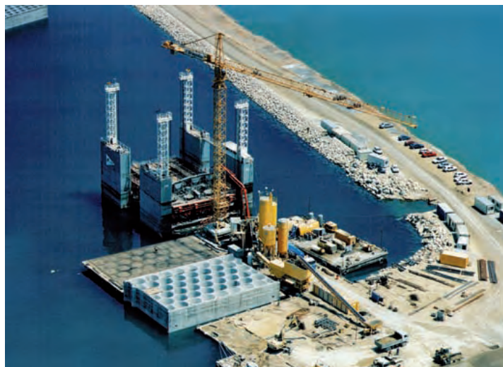
Figura 6.12.1 C Fabricación de cajones
