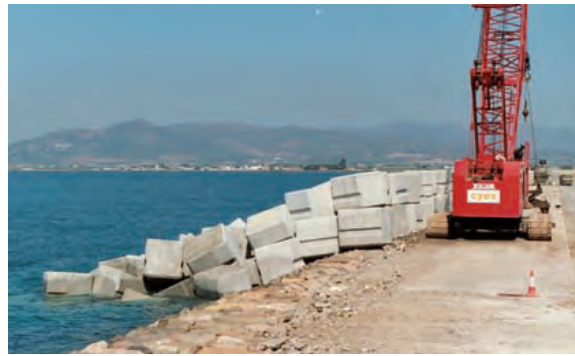
Figura 6.10.2 K Manto de escollera artificial
