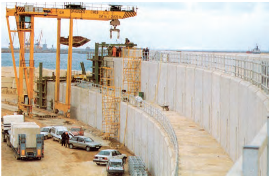
Figura 9.2.2 B Construcción espaldón
