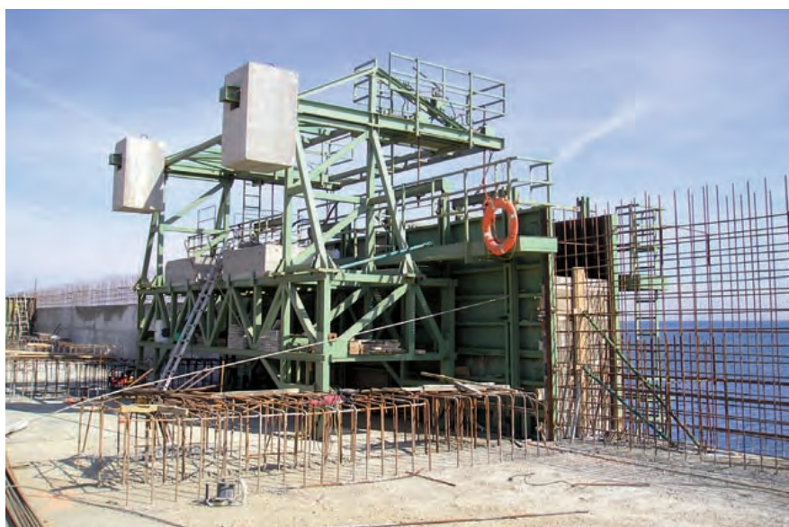
Figura 9.4.3 A Encofrado viga cantil
