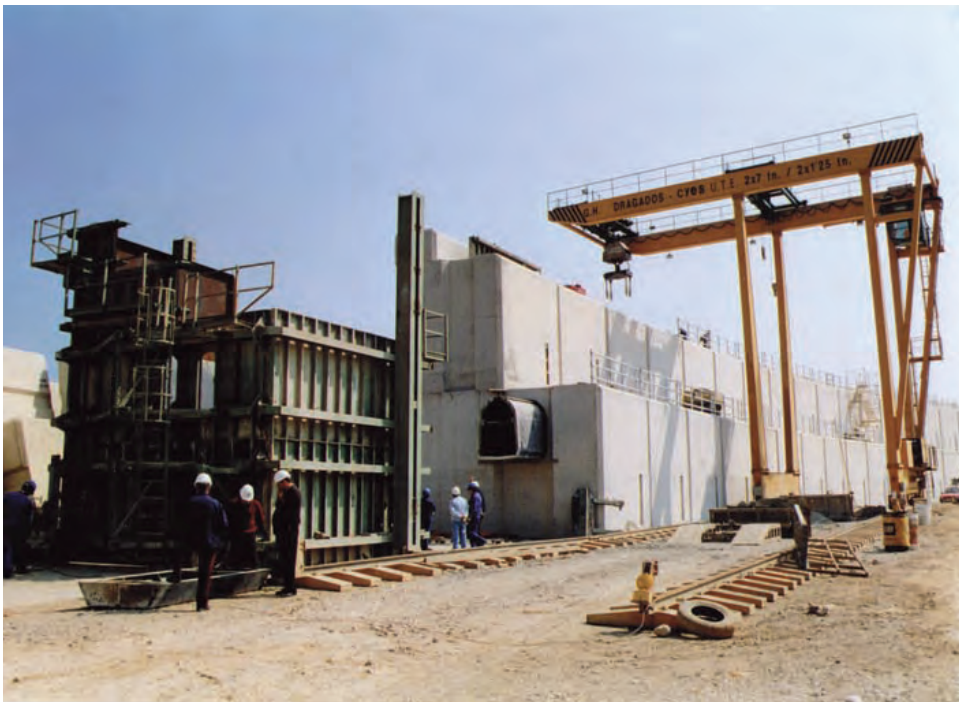
Figura 9.2.2 A Construcción espaldón con galería
