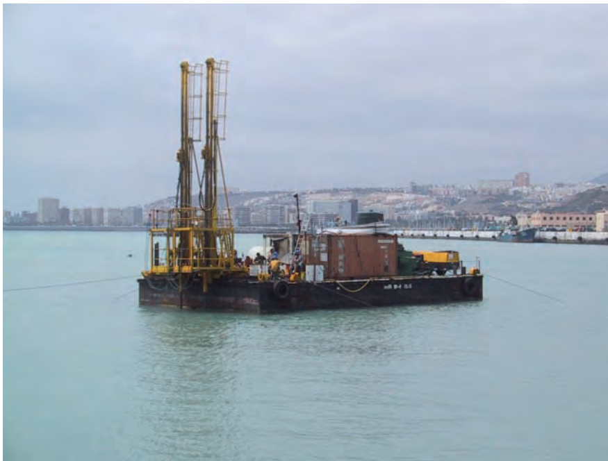
Figura 6.1.3 P Pontona para perforación
