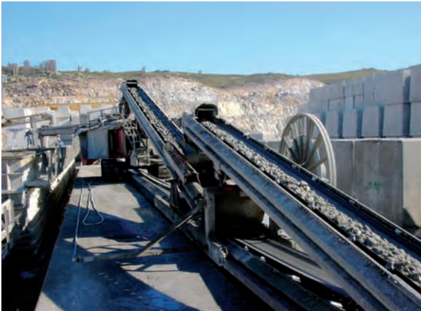
Figura 6.11.2 A Hormigonado con cinta
