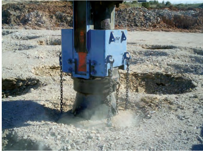
Figura 6.3.5 C Compactación dinámica rápida
