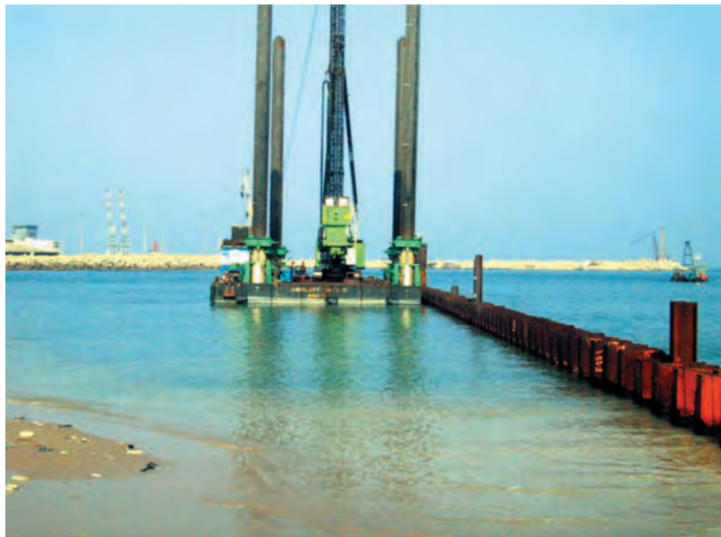
Figura 8.3.4. A Hincia de tablestacas con medios marítimos
