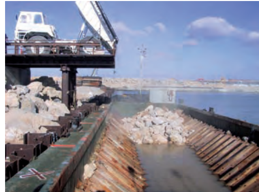
Figura 8.4.5 B Descarga en gánguil
