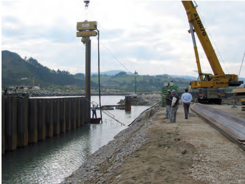
Figura 8.3.2 Hinca de tablestacas desde plataforma terrestre
