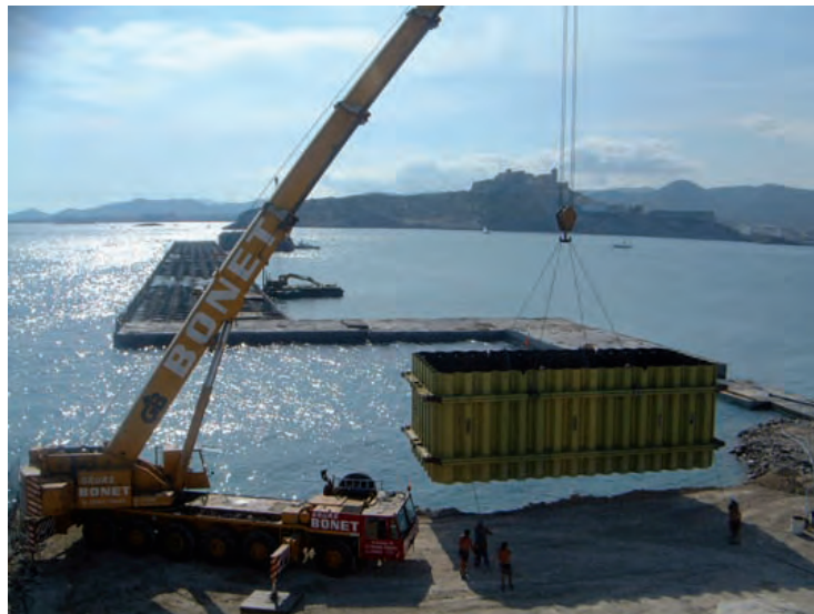
Figura 10.5.1 J Encofrado a cuatro caras
