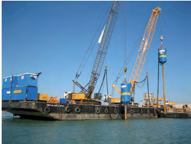
Figura 6.3.7 A Columnas de grava en fondo marino
