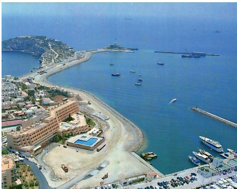
Figura 10.1 A Dique en construcción
