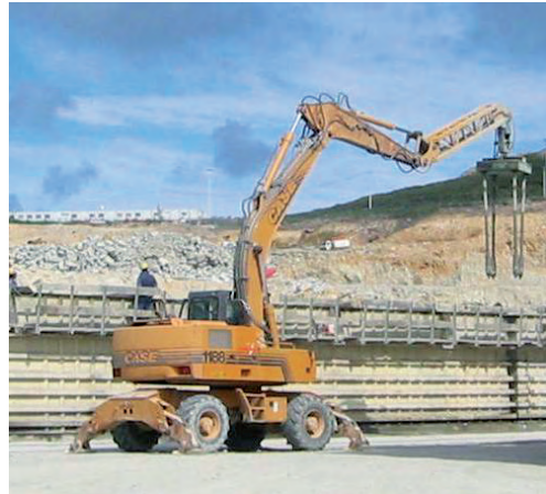
Figura 6.11.2 B Vibradores
