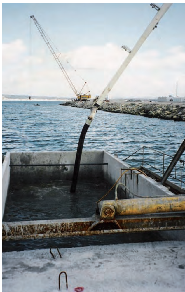
Figura 8.1.3.e Hormigonado con bomba
