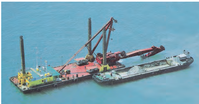
Figura 6.1.3 H Draga retroexcavadora
