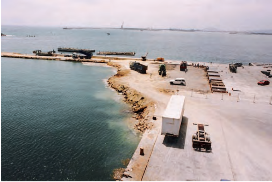
Figura 6.2.1.b A Colocación de relleno
