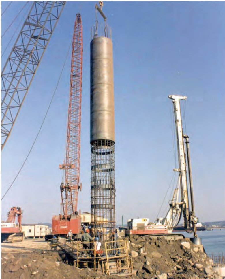
Figura 8.2.2.b B Colocación de armaduras
