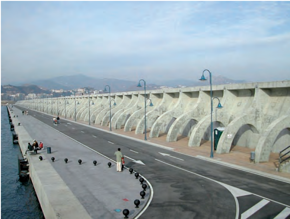
Figura 7.2.1 B Dique-muelle de Málaga
