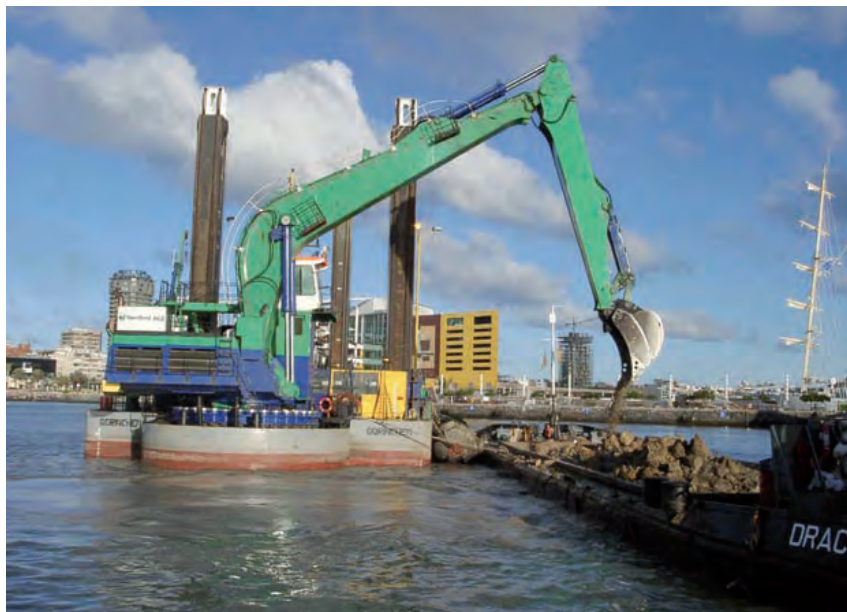
Figura 6.1.3 G Draga retroexcavadora
