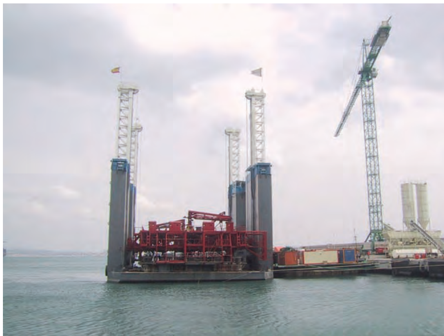
Figura 10.5.1 D Dique flotante nº 2
