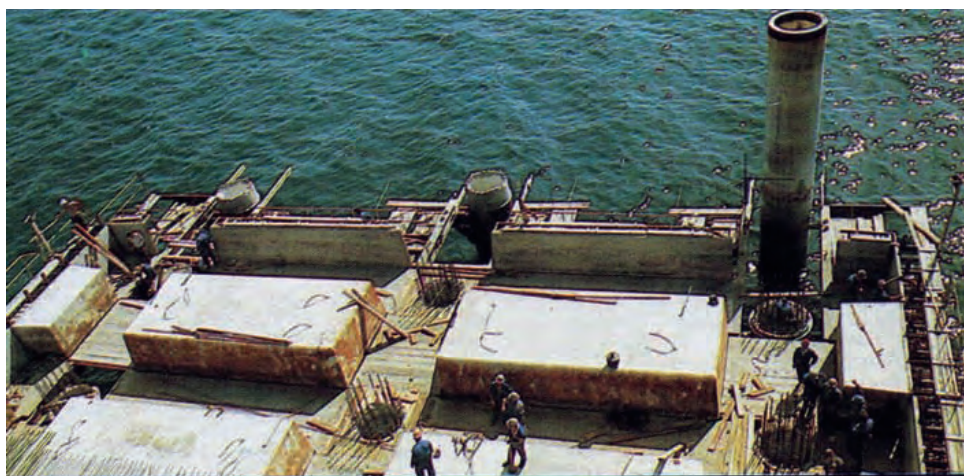
Figura 9.6.2 C Superestructura hormigonada “ in situ ”
