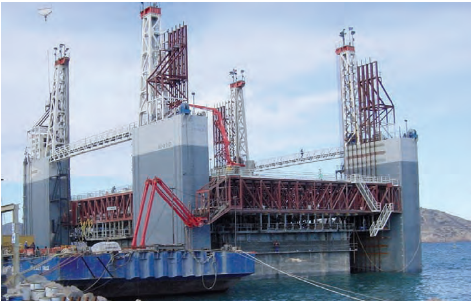
Figura 6.12.2 A Dique flotante
