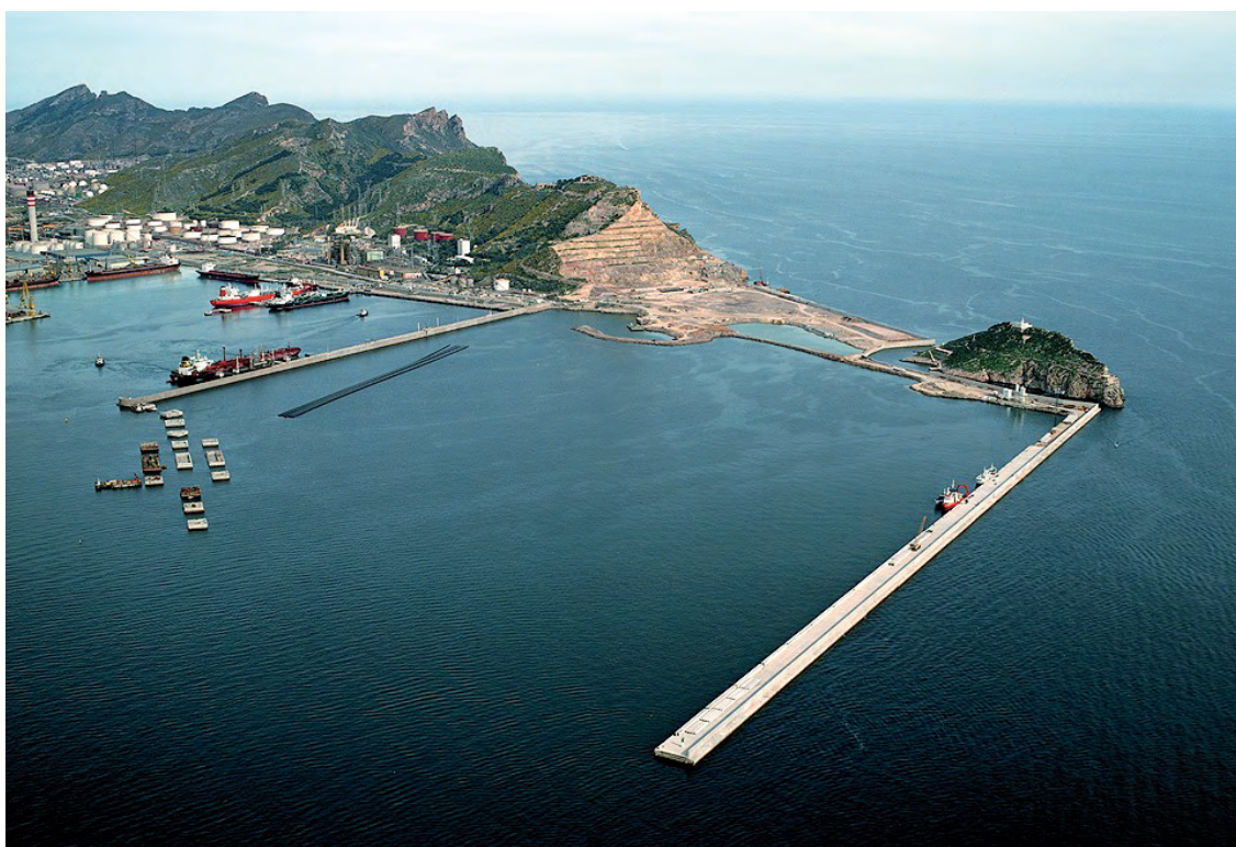
Figura 6.9.1 B Desmante de la propia obra
