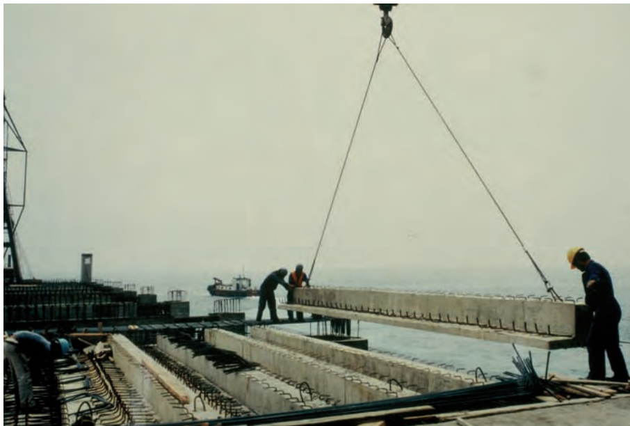
Figura 9.6.2 B Montaje de prefabricados
