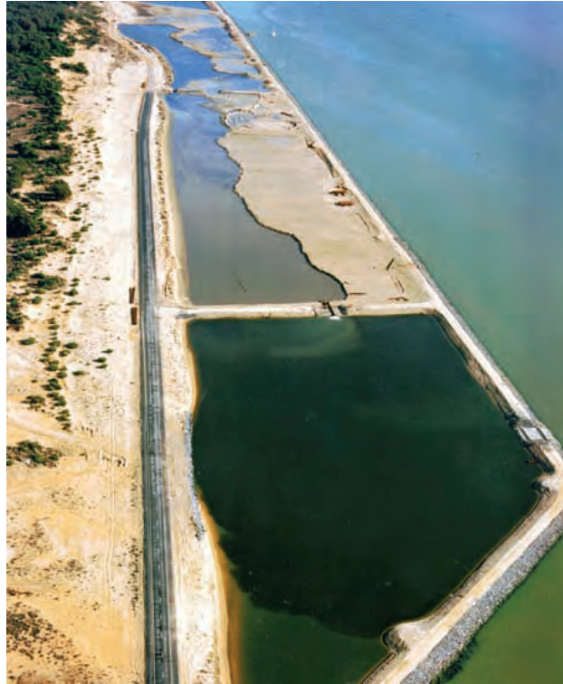
Figura 6.2.3.a Relleno con material contaminado
