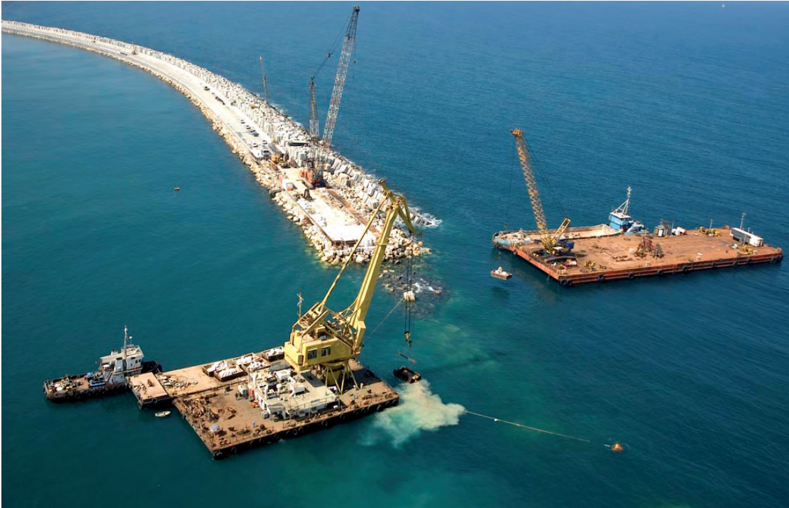
Figura 7.1.8.a D Pontonas colocando escollera
