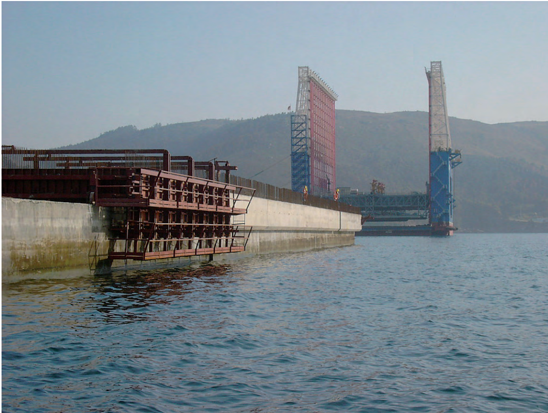
Figura 9.4.3 B Encofrado viga cantil
