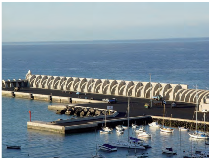
Figura 9.3.1 Espaldón de dique vertical
