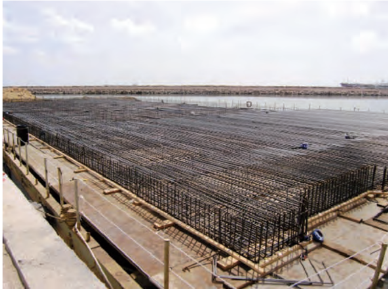
Figura 6.12.5 Armadura solera
