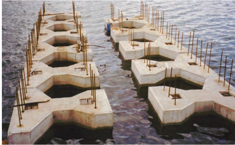
Figura 8.1.3.d A Encofrado perdido
