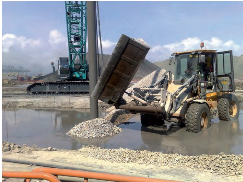
Figura 6.3.7 B Ejecución Columnas de grava en tierra
