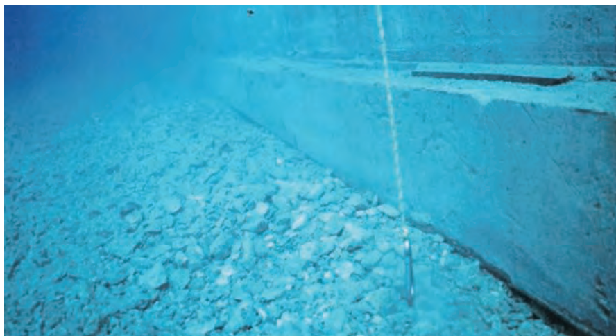
Figura 6.8.4 Comprobación del enrase tras fondear el cajón
