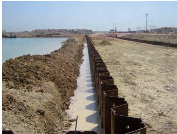
Figura 8.3.3.g A Pantalla de tablestacas
