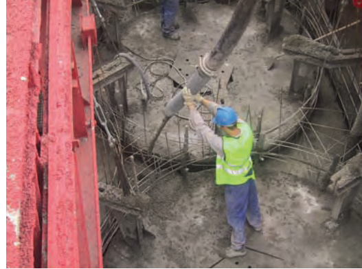
Figura 6.12.6 B Hormigón del fuste
