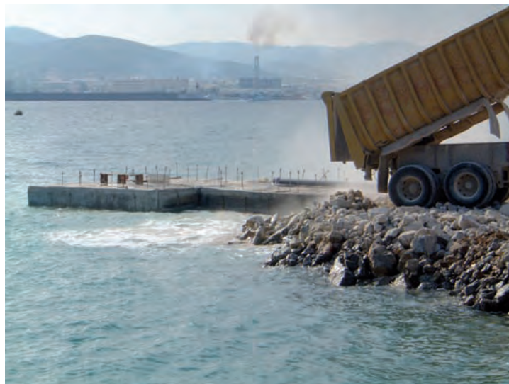
Figura 6.4.1 Relleno de trasdós
