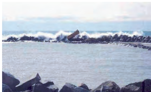
Figura 7.1.3 B Rebases durante la construcción de un dique
