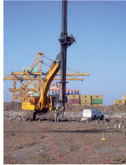
Figura 6.3.6 C Colocación mechas
