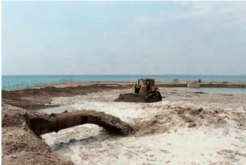
Figura 6.2.2.b A Relleno con tubería
