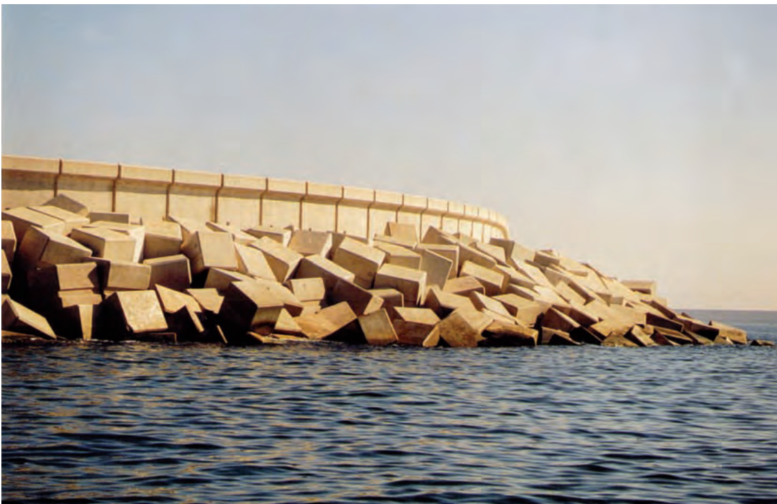
Figura 7.1.10.a Espaldón de dique en talud
