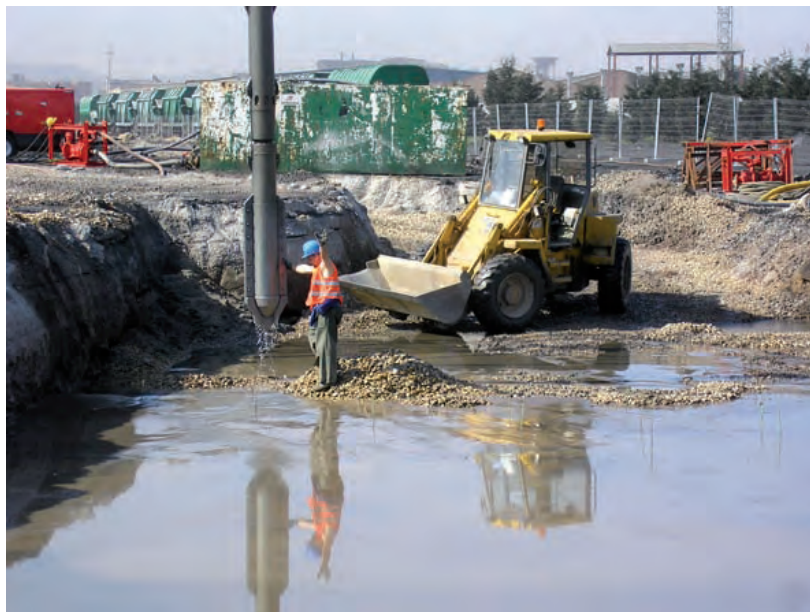
Figura 6.3.4 Vibrosustitución
