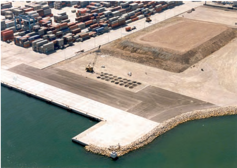
Figura 6.3.5 A Compactación dinámica y precarga
