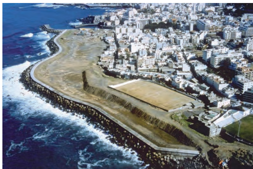
Figura 6.10.2 B Manto de protección ante el oleaje
