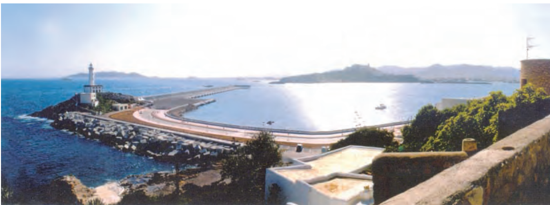
Figura 10.1 B Dique Botafoc
