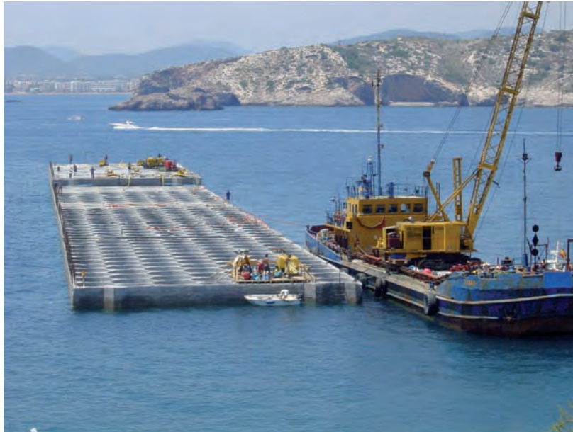
Figura 10.5.1 H Retirada equipo fondeo
