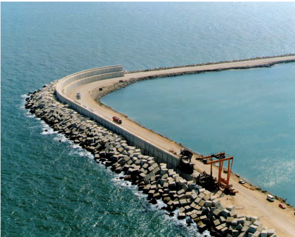
Figura 7.1.10.b Ejecución del espaldón del dique
