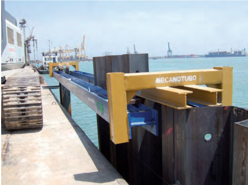
Figura 8.3.3.f Guía de tablestacas
