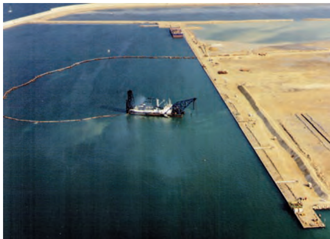
Figura 6.2.2.a Relleno procedente de dragado
