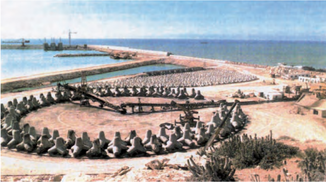
Figura 6.11.2 E Parque circular de fabricación de Tetrápodos
