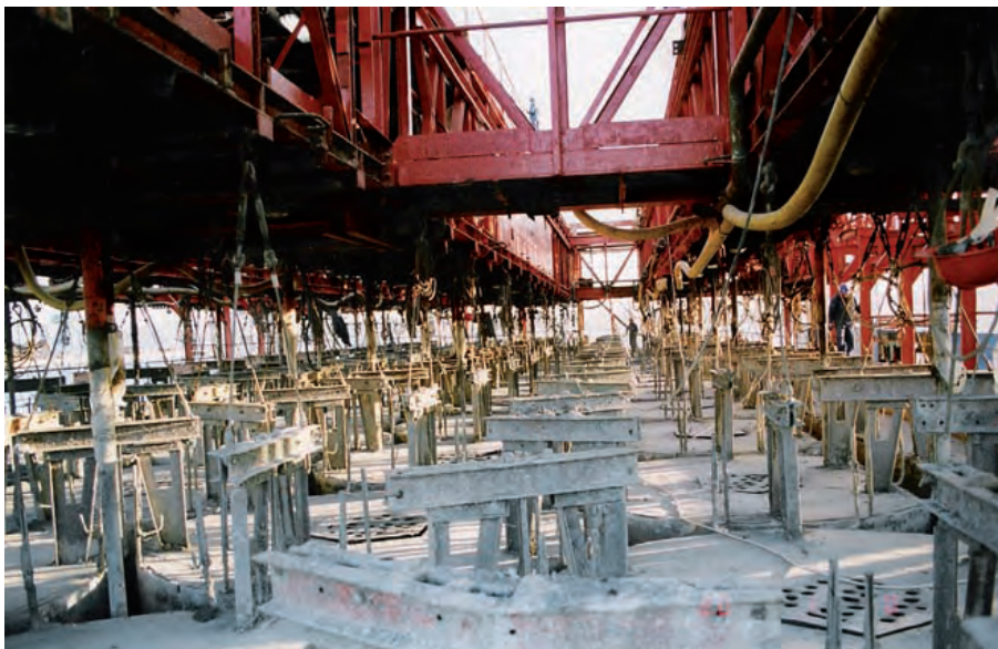
Figura 6.12.2 B Encofrados
