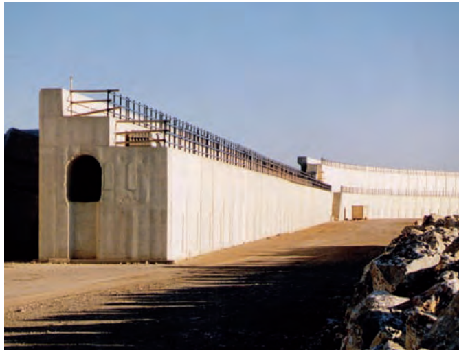
Figura 9.2.1 B Espaldón con galería
