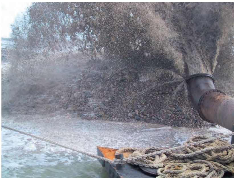
Figura 6.2.2.b B Relleno hidráulico
