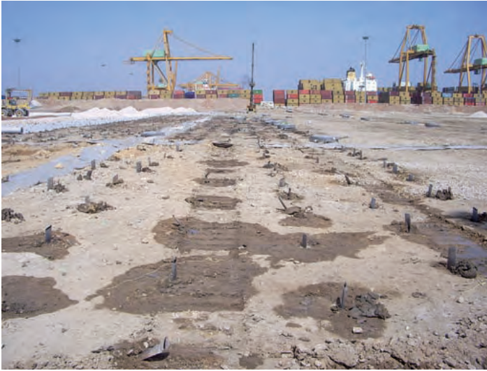
Figura 6.3.6 B Mechas de geotextil
