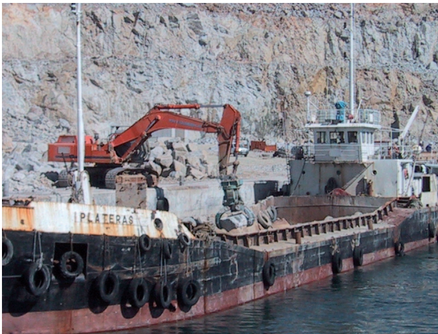
Figura 8.4.5 C Descarga en gánguil con retroexcavadora.
