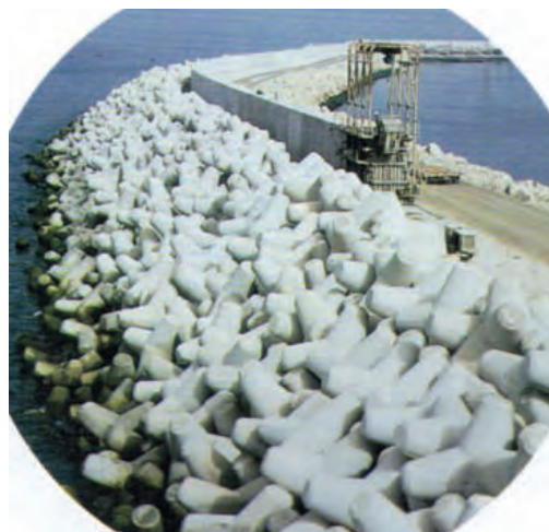
Figura 6.11.1 D Manto de Tetrápodos
