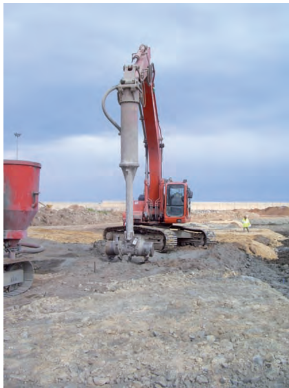
Figura 6.3.8 B Mezclador para estabilización en masa
