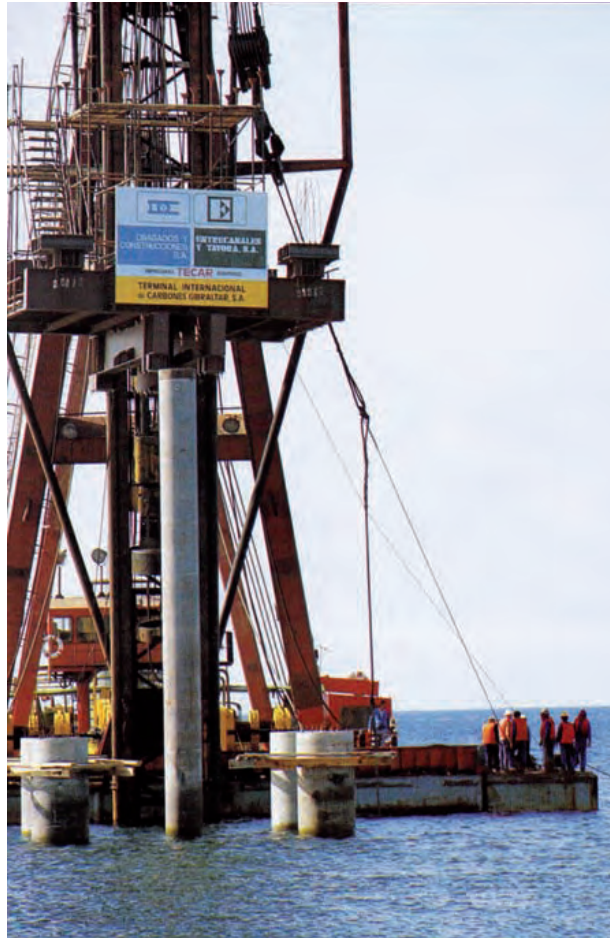
Figura 8.2.5.f Prueba de carga
