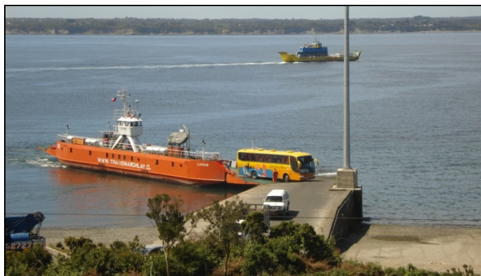
Figura 1.3.1-2: Rampa de doble pendiente (Chacao)
