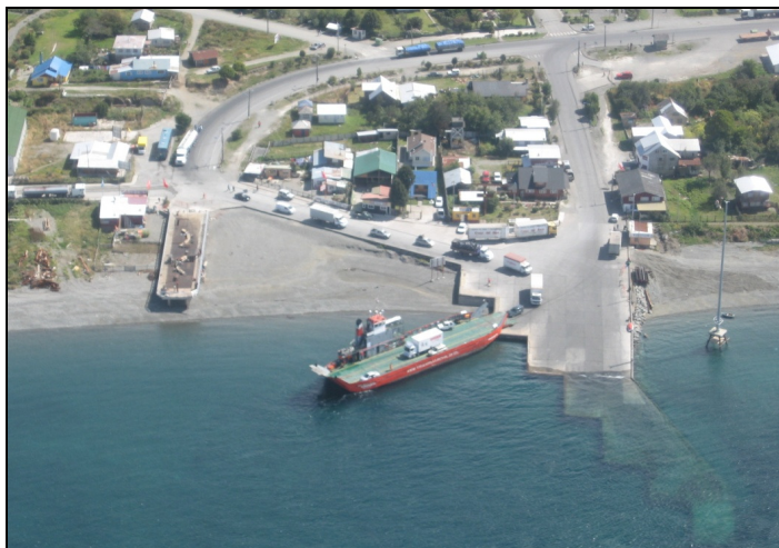
Figura 1.3.1-3: Rampa de varios niveles (Pargua)
