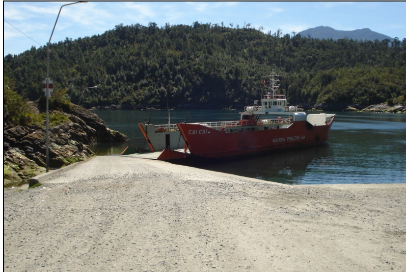
Figura 1.3.2-1: Foto Transbordador operando en rampa Puelche
