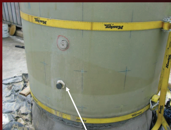
bombeo del grout
