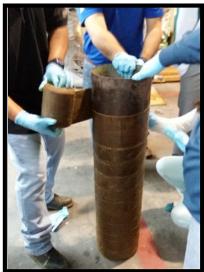
Preparación superficial del pilote.
