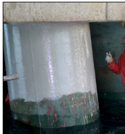
Aplicación de rigspray mediante airless o brocha, en 1 o 2 capas
