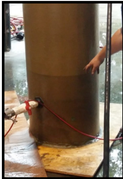
Instalacion de chaqueta en fibra de vidrio alrededor del pilote.
