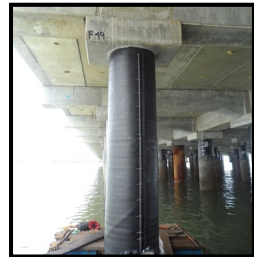
Ajuste de chaqueta usando pistolas neumáticas.
