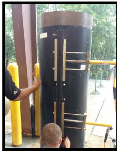
Aplicación de imprimante prepaste S105.
