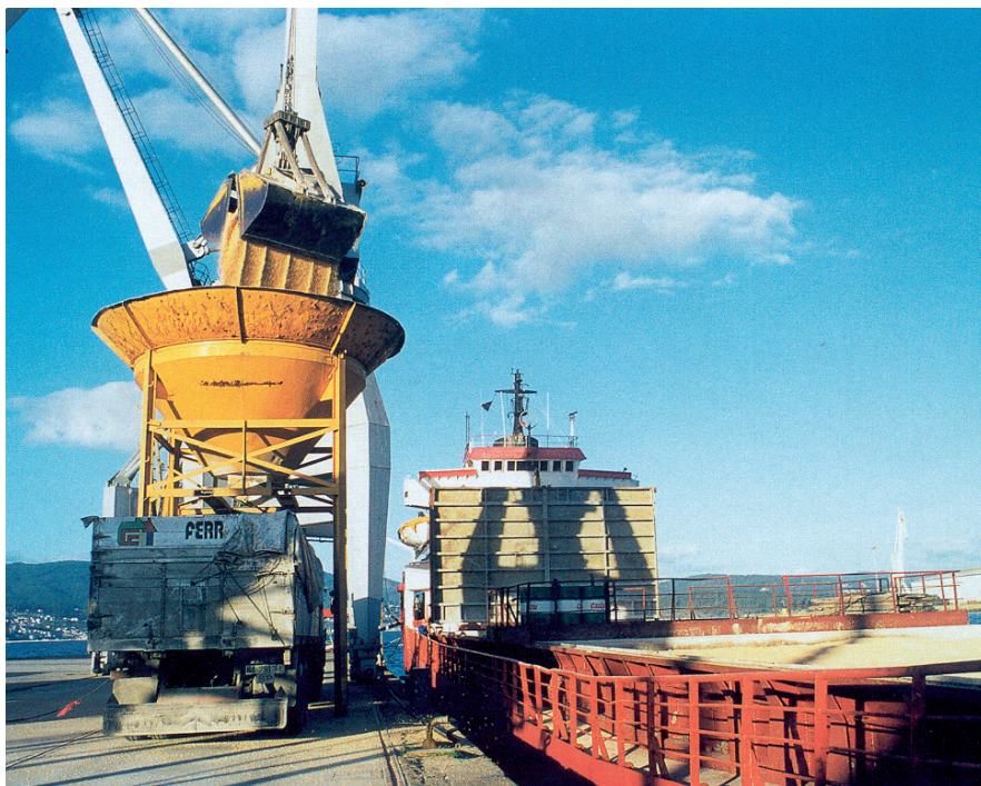
Instalación portuaria para descarga de grano
