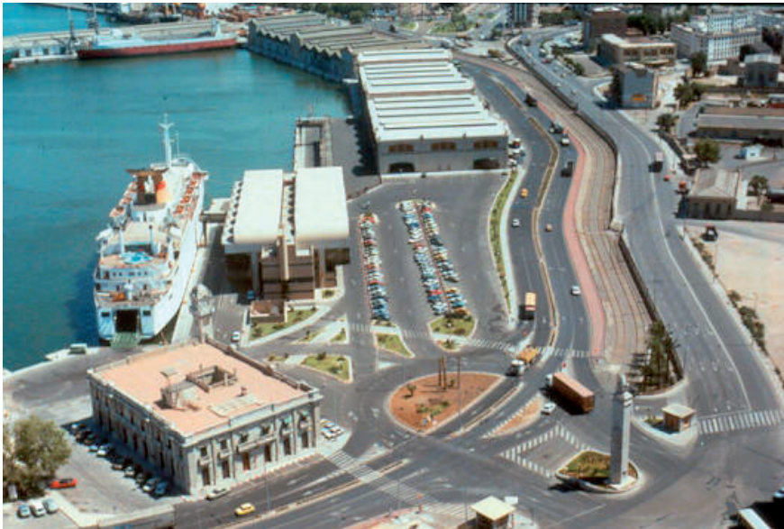
Antigua terminal de pasaje del Puerto de Valencia
