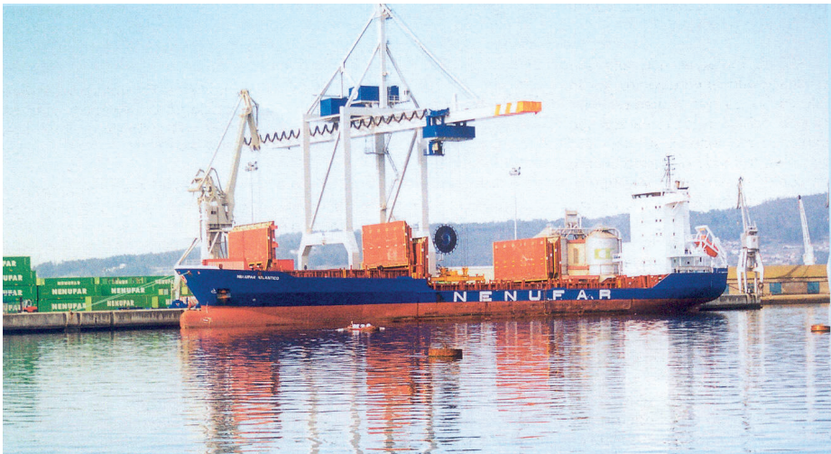
Grúa en terminal de contenedores
