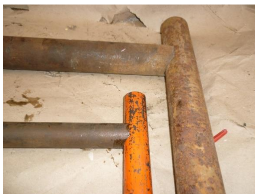
Figura 24. Corte boca de pescado en tuberías. Fuente: Elaboración propia.
